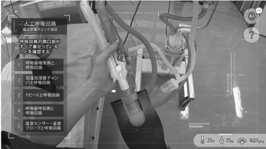
図5 人工呼吸器の正確な点検作業手順の表示（左側）と肉眼での確認
